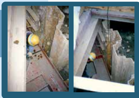
内型枠設置工
