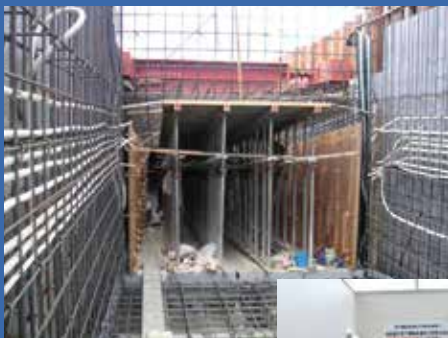
地下歩道工事
