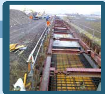
内型枠設置工
