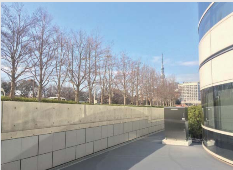
沈下対策、荷重軽減
