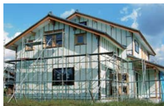
外張断熱工法（ミラフォーム）
