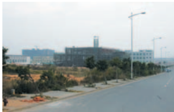
東莞工場建築用地 (建設中建物が境界で手前部分)
