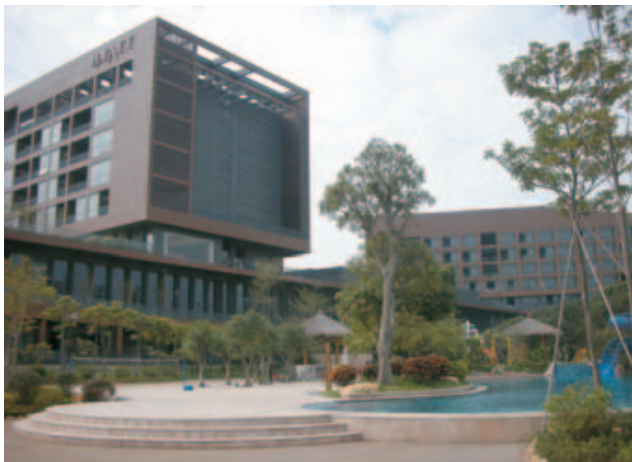
開発地内のリゾートホテル
