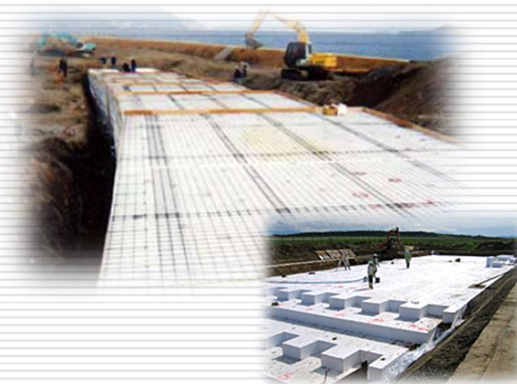
軟弱地盤の沈下対策 (発泡スチロール土木工法)
