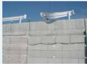
【(独)北海道開発土木研究所・EPS開発機構】 1年間常時微動観測、交通荷重載荷実験、 ガードレール衝突実験など
