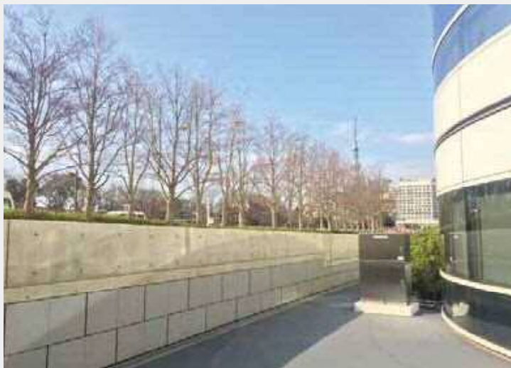
沈下対策、荷重軽減
