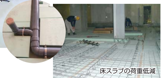
配管埋設のための嵩上げ
