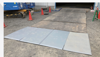
工場出入口の養生
