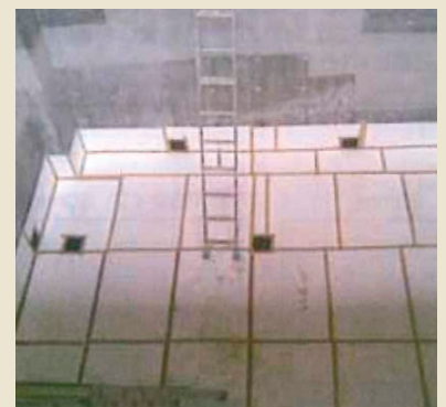
機械式駐車場
