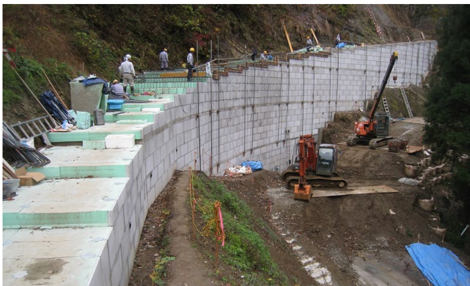
J-ウォールブロック 施工例
